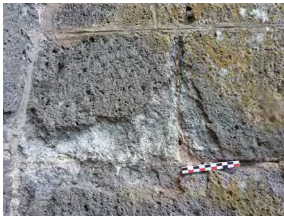
Cathédrale Saint-Etienne, Agde : cristallisations salines à l'origine d'une desquamation en plaque du basalte.
