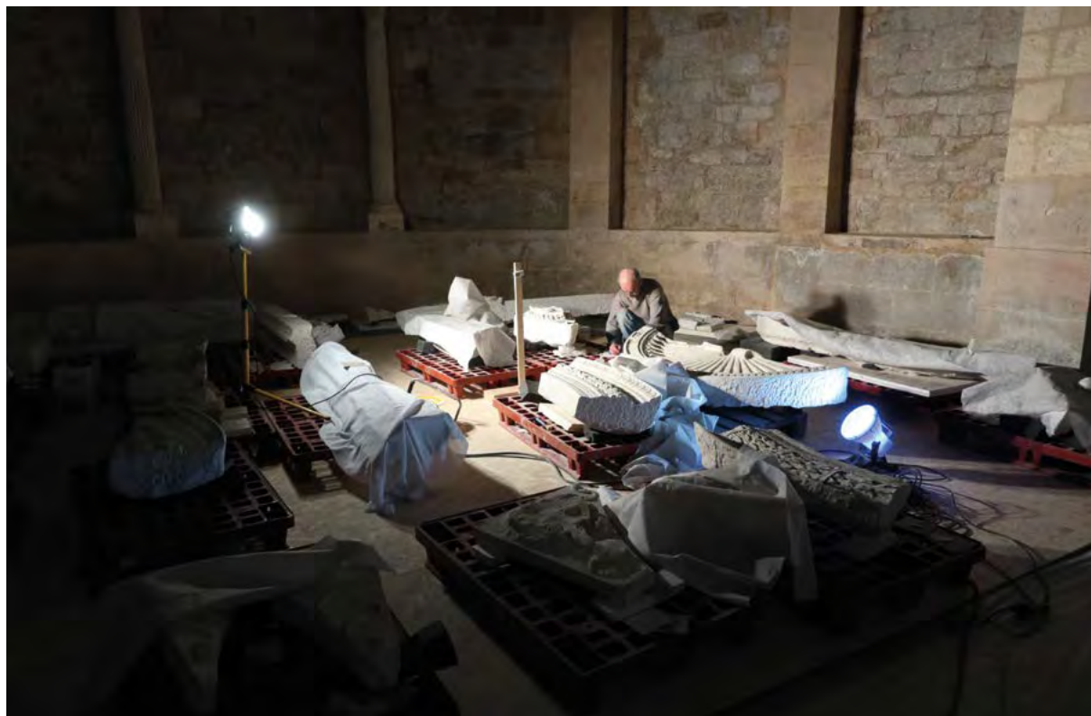
Église de la Vieille Major, Marseille : examen par Benoît Lafay (restaurateur) des blocs de marbre après leur dessalement, afin de déterminer les interventions de conservation-restauration à mener avant leur remontage.
